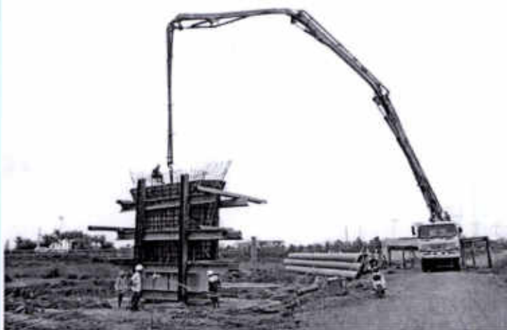
Dự Án Trung Lương – Mỹ Thuận đang thực hiện thi công
